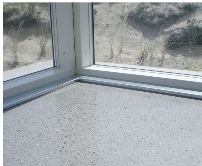
Slebet og poleret gulvbeton
